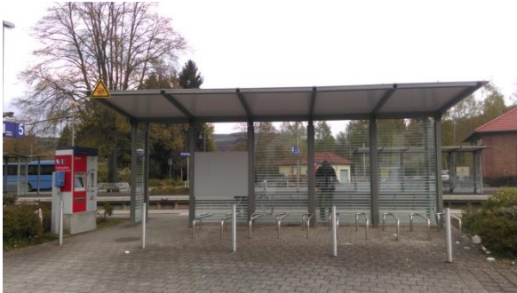
Abbildung 24: B+R mit direktem Zugang zum Bahnsteig
